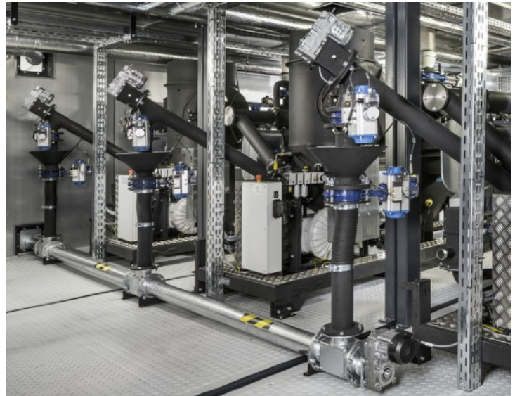
500 KW system i container med flis matare
